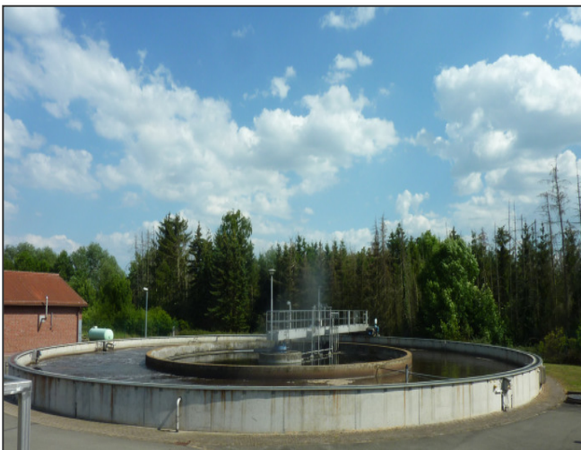
Blick auf die Biologische Abwasserreinigung
